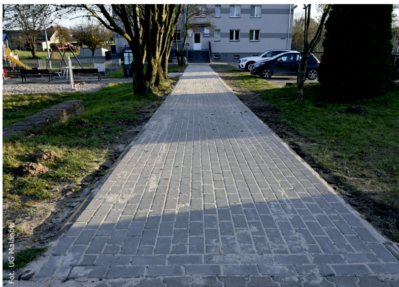
Wyremontowany chodnik prowadzący do ośrodka
